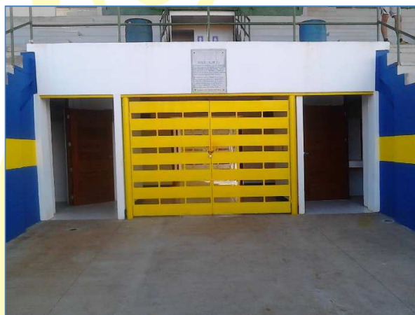
Acceso a los servicios sanitarios públicos, apreciar la remodelación total, instalación de puertas de madera, portón de acceso, aparatos sanitarios.
