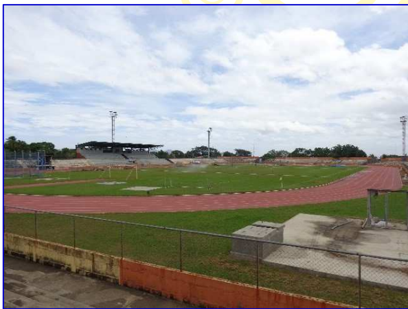
Vista panorámica de la Pista de Atletismo, ala izquierda apreciar situación de la pista sin proyecto y a la derecha observar el reemplazo del piso sintético de poliuretánico de 14 mm de espesor en color, situación con proyecto.
