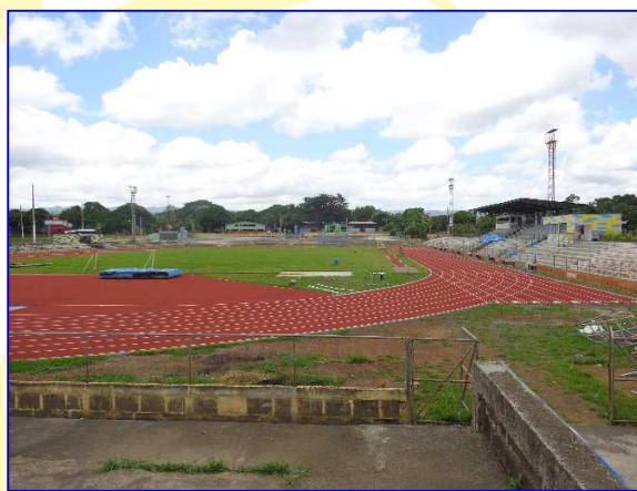
Vista panorámica de la Pista de Atletismo, ala izquierda apreciar situación de la pista sin proyecto y a la derecha observar el reemplazo del piso sintético de poliuretánico de 14 mm de espesor en color, situación con proyecto.
